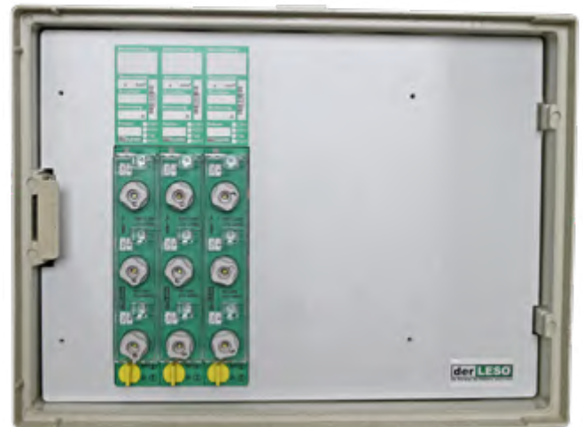
Fertig eingebaut mit Abdeckung
